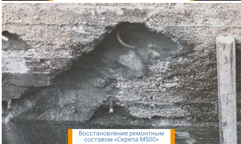
С использованием ударного инструмента производим частичную разборку стены
