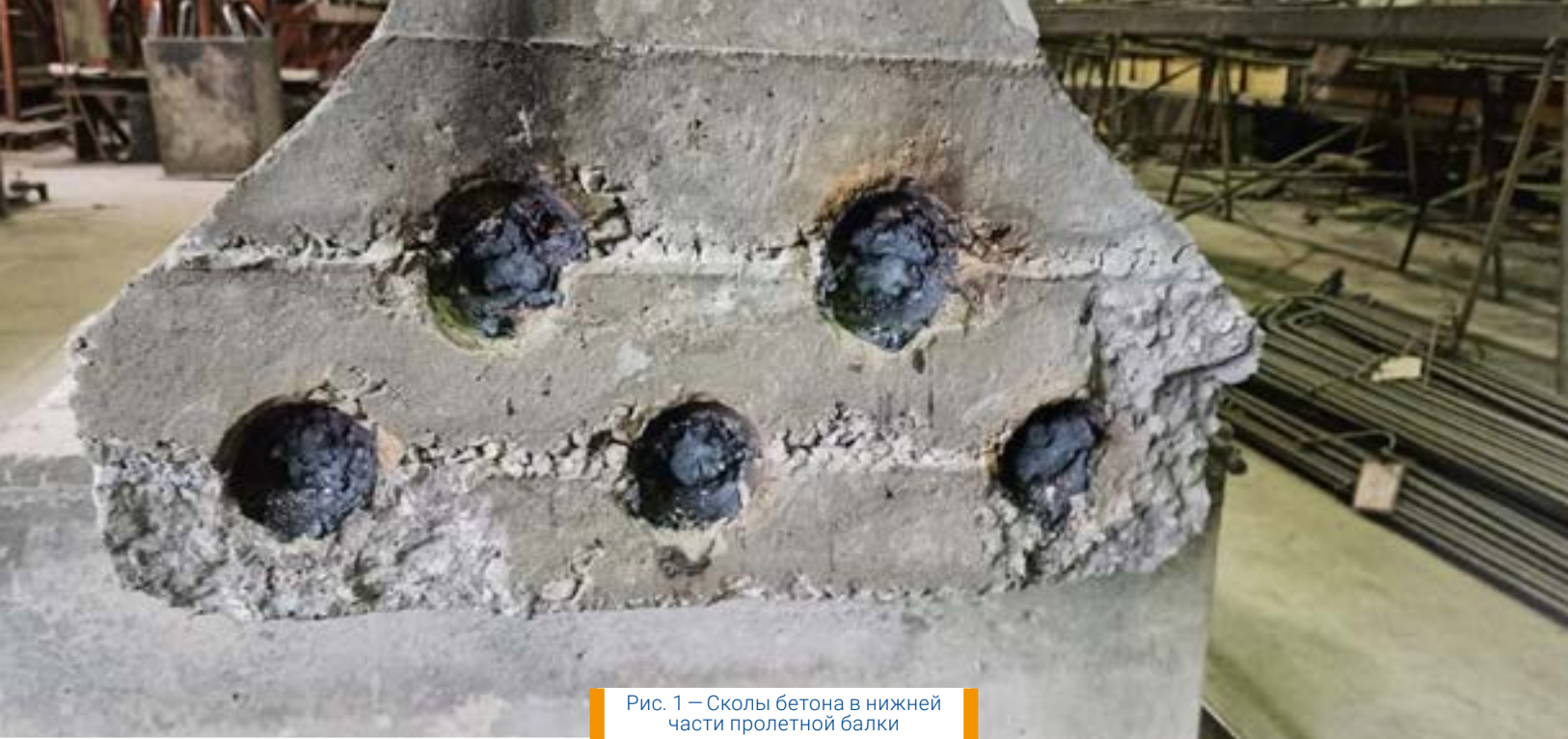
Рис. 2 – Для пролетных балок неприемлемы и мелкие дефекты
