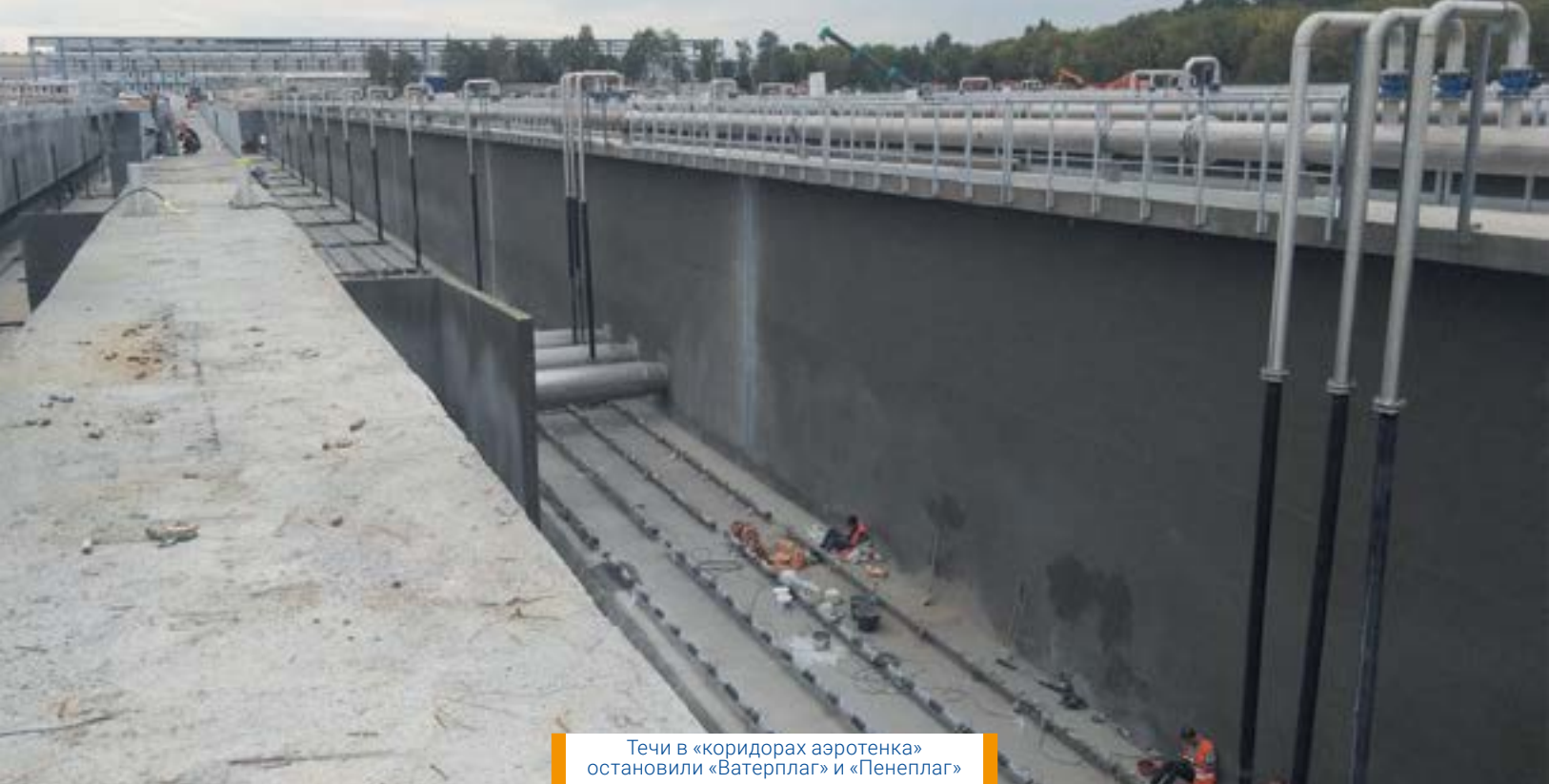
Гидроизоляция деформационных швов системой Пенепланд С
