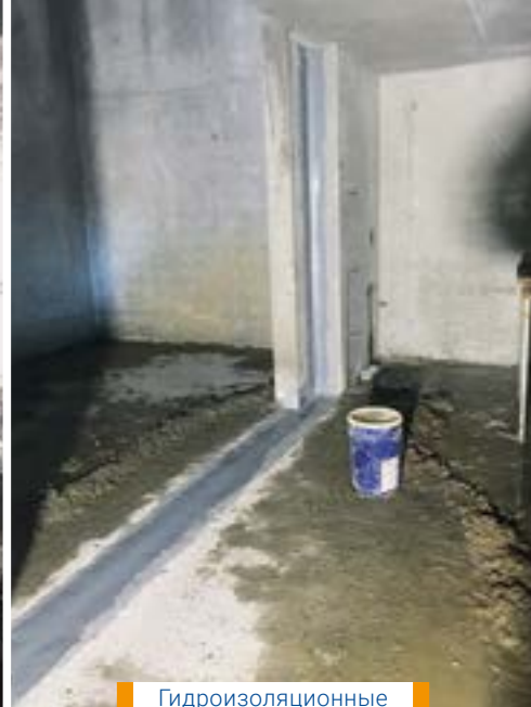
Гидроизоляционные работы: до и после
