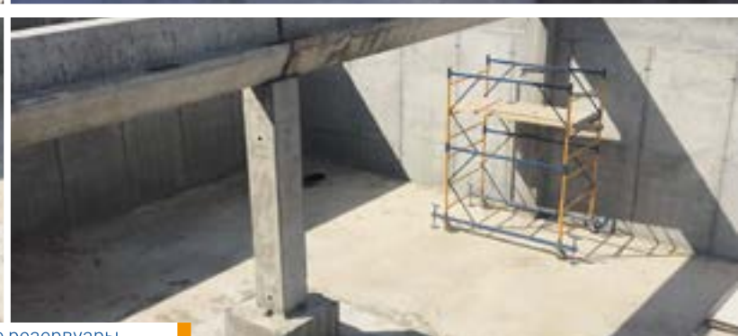
...Пожарные резервуары... Все обработано «Пенетроном»!
