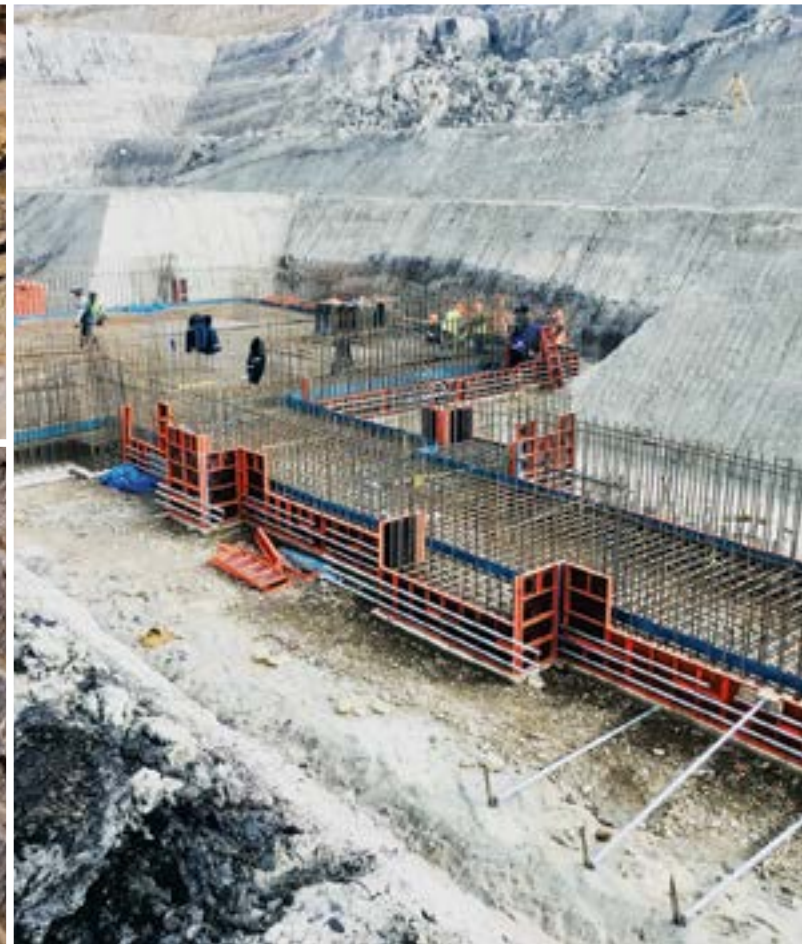
Причалы забетонированы с «Пенетрон Адмиксом»
