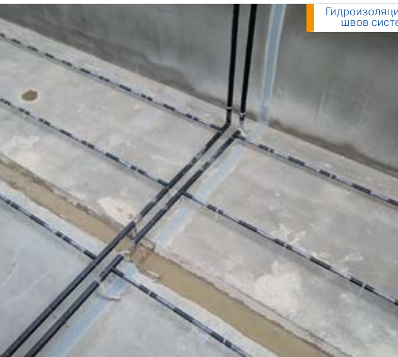
Течи в «коридорах аэротенка» остановили «Ватерплаг» и «Пенеплаг»
